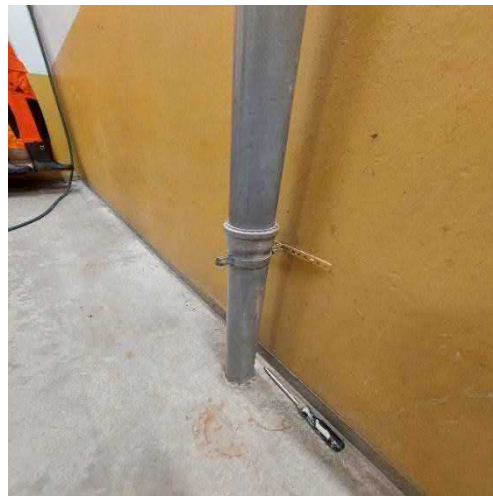
Muovinen sadevesiviemäri kiinteistön laajennusosalla.
