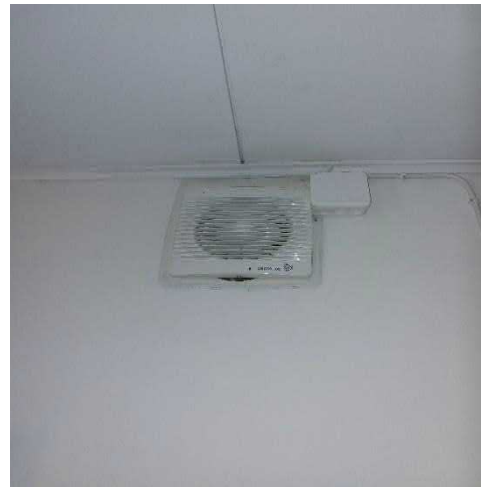
Wc-tilan ilmanvaihtoa tehostettu seinään asennetulla puhaltimella.
