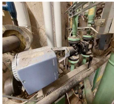
Lämmitysverkoston säätöventtiili.
