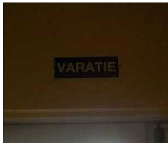
Jälkivalaiseva poistumistiekyltti oven yläpuolella
