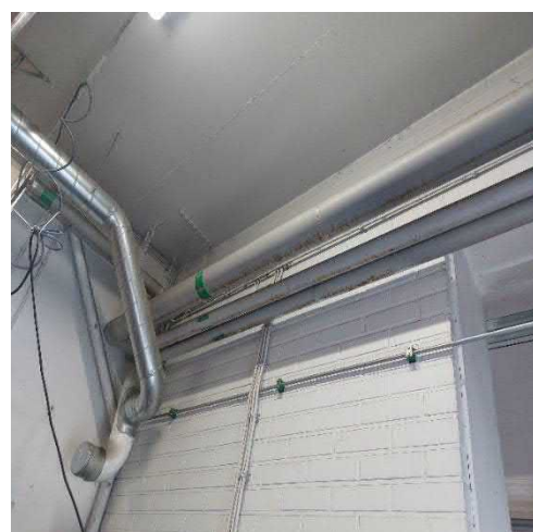
Pakokaasunpoistokanava laajennusosalla.
