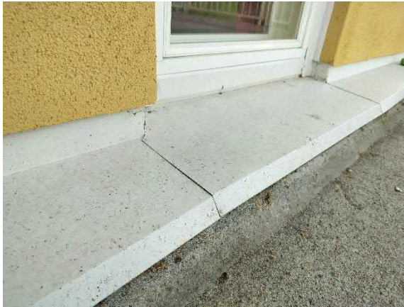
Alkuperäisen rakennusosan uusittuja ikkunoita
