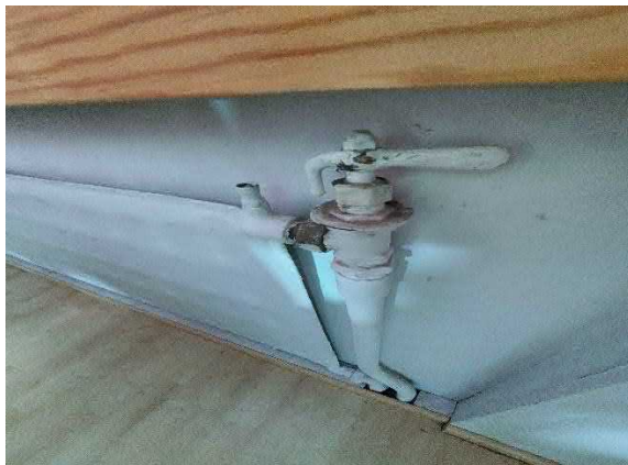
Alkuperäinen patteriventtiili.
