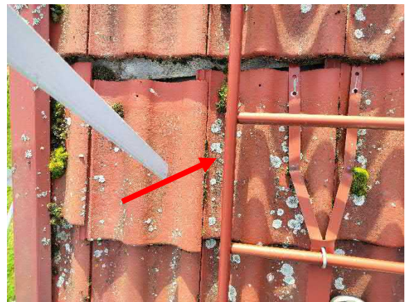
Rikkoutuneita kattotiiliä
