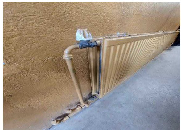
Patteriventtiili käsisäätöpyörällä.
