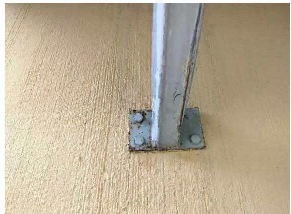
Kondensoituneen veden vaurioittama teräsrakenne
