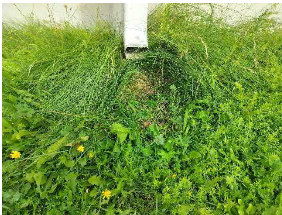
Etelänpuoleisen lappeen sadevedenpoisto
