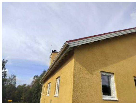
Yleiskuva rakennuksen kaakkoiskulmalta
