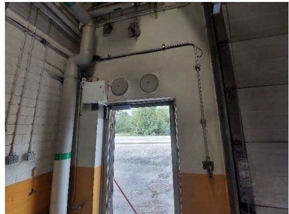
Autohallin korvausilmaventtiilit.
