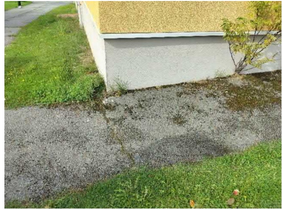
Alkuperäisen rakennusosan perusmuuri
