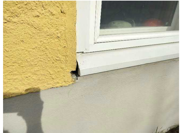
Alemman kerroksen vesipellin liitos ikkunoita
