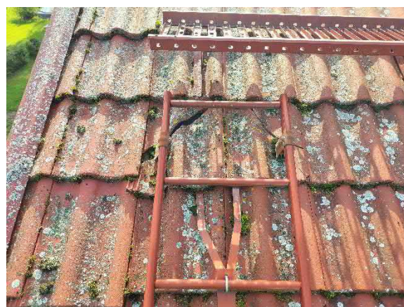
Rikkoutuneita kattotiiliä
