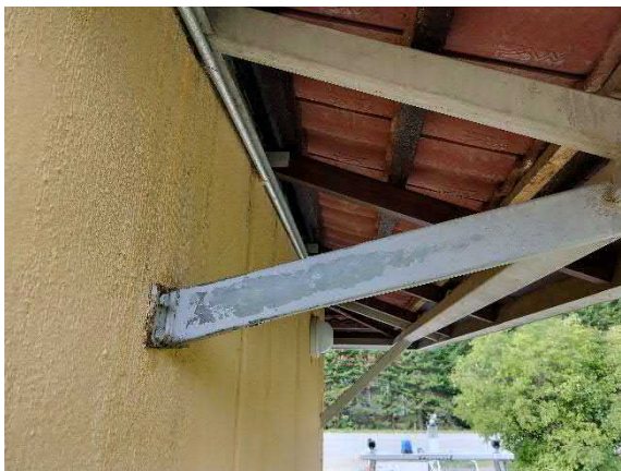
Kondensoituneen veden vaurioittama teräsrakenne
