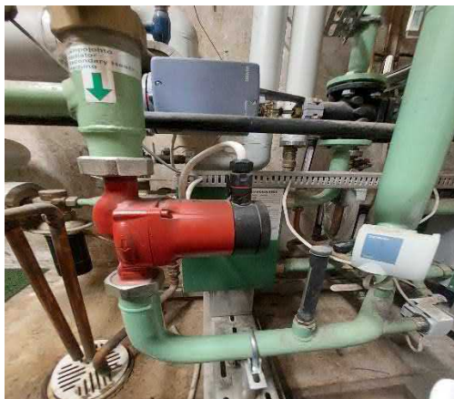
Lämmitysverkoston kiertopumppu.
