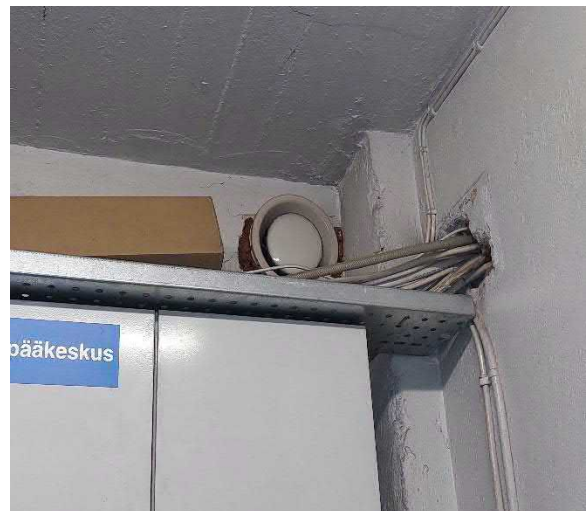
Poistoilmaventtiili sähköpääkeskussa.
