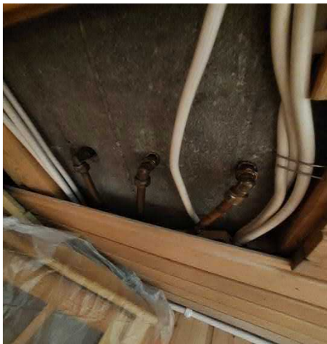
Alkuperäisiä vesijohtoja seinän sisällä.
