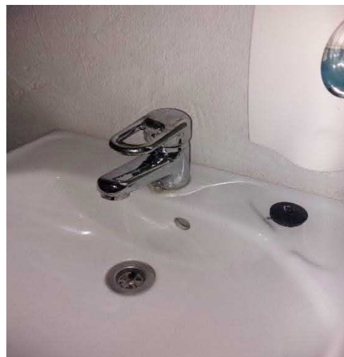
Uusittu pesuallashana wc:ssä.
